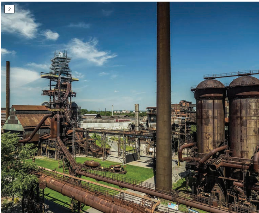
Obr. 1: Manufaktura Lodz, konverzia textilnej továrne (foto: Sebastian Glapinski). Obr. 2: Dolní oblast Vítkovice (kudyznudy.cz). Fig. 1: Manufaktura Lodz, conversion of a textile factory (photo: Sebastian Glapinski). Fig. 2: Lower Vítkovice area (kudyznudy.cz).
