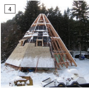
Obr. 1: Rozoberanie starej strechy, november 2005 (foto: Lubomír Lužina). Obr. 2: Osádzanie centrálneho piliera, december 2005 (foto: Lubomír Lužina). Obr. 3: Montáž krovu, december 2005 (foto: Lubomír Lužina). Obr. 4: Ukladanie šindľa, december 2005 (foto: Lubomír Lužina). Obr. 5: Dokončená strecha, marec 2006 (foto: Lubomír Lužina). Obr. 6: Hotová stavba, jún 2006 (foto: Lubomír Lužina).
